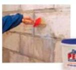
**Грунтовка** – глубокого проникновения. Выравнивает впитывающую способность стен. Обеспыливает. Укрепляет основание.
