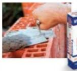
**TKC или Теплая кладочная смесь** – кладочная смесь с пониженным коэффициентом теплопроводности. Применяется в качестве раствора для кладки из поризованных керамических блоков и камней.
