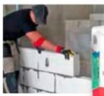
**Vlokus** – сверхпластичная клеевая смесь для монтажа блоков и плит из ячеистого бетона, газосиликата и газобетона. Исключает появление «мостиков холода» благодаря шву 2-5 мм.
