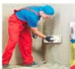
**ТерпoRob** – облегченная цементная штукатурная смесь с перлитом. Для выравнивания стен на фасаде и внутри зданий.
